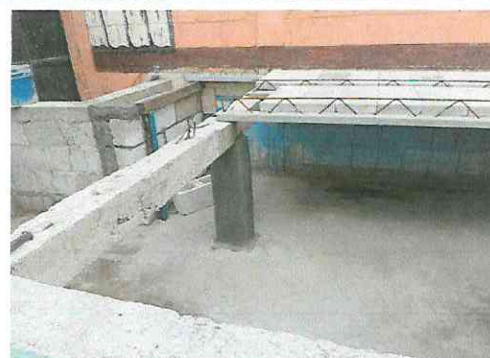
Foto 2: REPARACION DE LOSA DE ESEÑARIO
