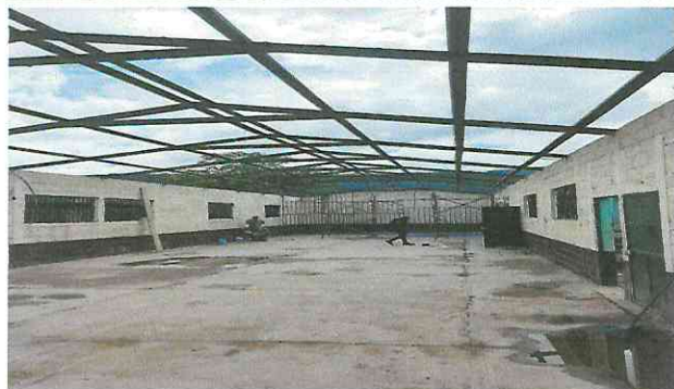
Foto1: CAMBIO DE CUBIERTA DE LAMINA AL SALON DE USOS MÚLTIPLES
