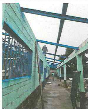
Foto 3: MANTENIMIENTO A PUERTAS Y ESTRUCTURA CAMBIO DE CHAPA A PUERTAS
