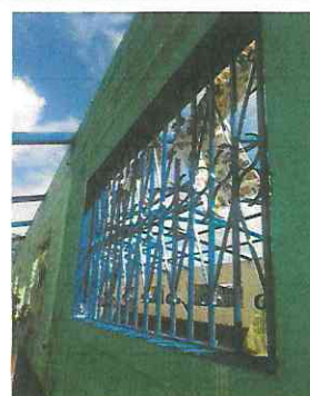
Foto 4: MANTENIMIENTO A BALCONES Y CABLEADO ELÉCTRICO DE SALÓN
